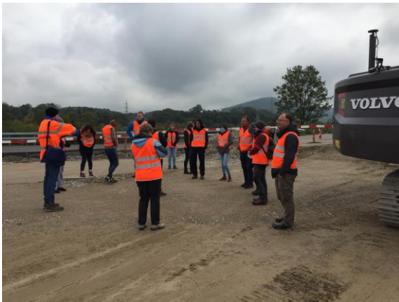
Abb. 1: Baustellenbesichtigung auf der neuen Rauricastrasse (Hunziker)
