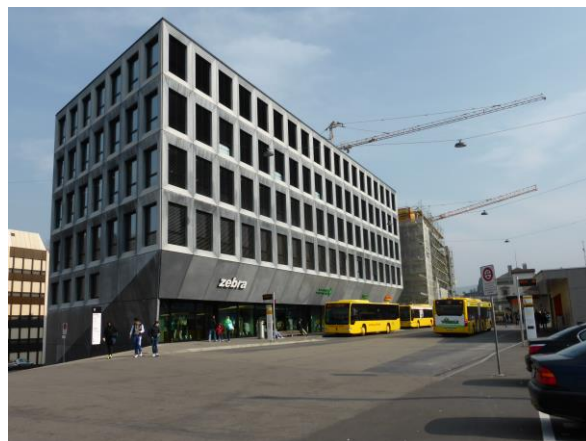
Abb. 2: Das Gebäude UNO, dahinter die Gebäude DUE und TRE (im Bau).
