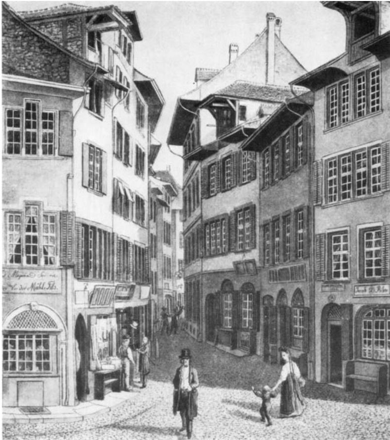
Abbildung 2: Blick Richtung Rhein, vor der Verbreiterung von 1839
