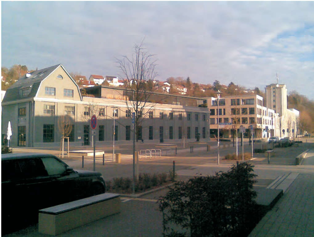
Abb. 6 Das heutige Stadtquartier "Alte Weberei" in Tübingen anstelle der früheren Egerie unter Erhalt von zwei identitätsstiftenden Gebäuden. Foto: E.-J. Schröder, 2018
