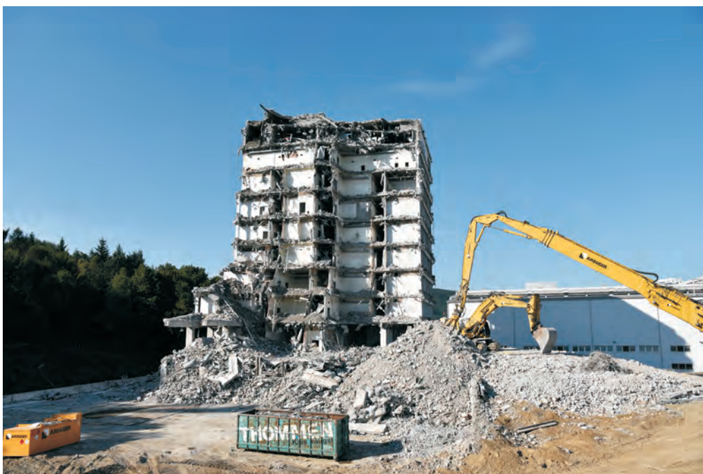
Abb. 4 Rückbau eines Betongebäudes im Raum Schweizerhalle bei Muttenz.
