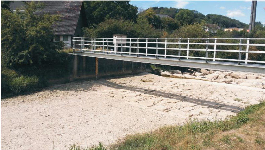
Abb. 1 Trockenfallen (Abfluss Q = 0.0 \text{ m}^3/\text{s} ) der Sissle in Eiken (AG) am 11. August 2018.
