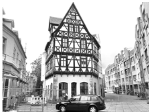
Halle v.l.n. r.: Gebäudesanierung - mittelalterliches Fachwerkhause - DDR-Plattenbau der gehobenen Klasse
